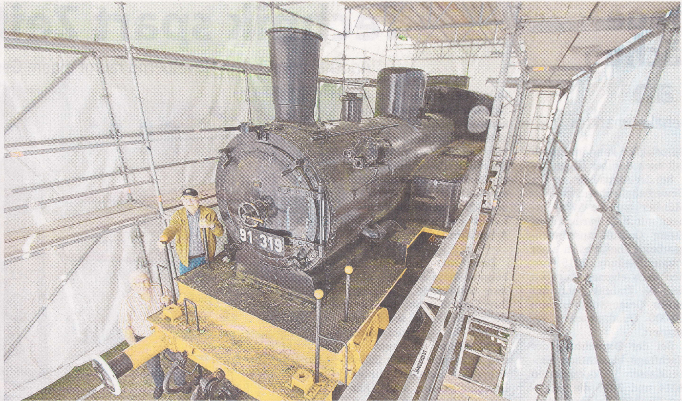
Die Pängelanton-Lok am Albersloher Weg / Ecke Erbdrostenweg ist unter einer Plane verschwunden. Pängelanton-Chef Jochem Lüke (l.) und Wolfgang Klein freuen sich, dass die Sanierung des Denkmals endlich beginnen kann. FOTO HPE
