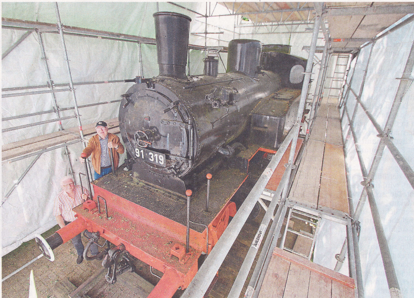
Die Pängelanton-Lok am Albersloher Weg / Ecke Erbdrostenweg ist unter einer Plane verschwunden. Pängelanton-Chef Jochem Lüke (l.) und Wolfgang Klein freuen sich, dass die Sanierung des Denkmals endlich beginnen kann.
